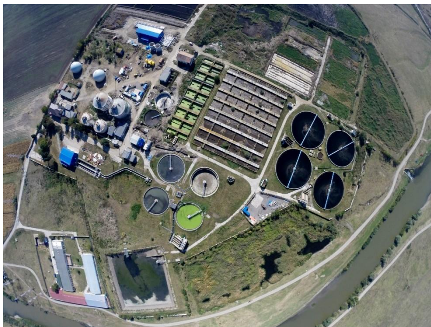
Stația de epurare Târgu Mureș (Foto AQUASERV)
