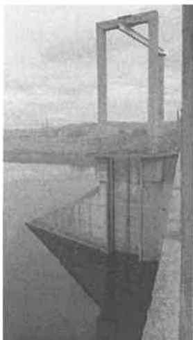
Foto 2. Instalația de manevrare a batardoului
