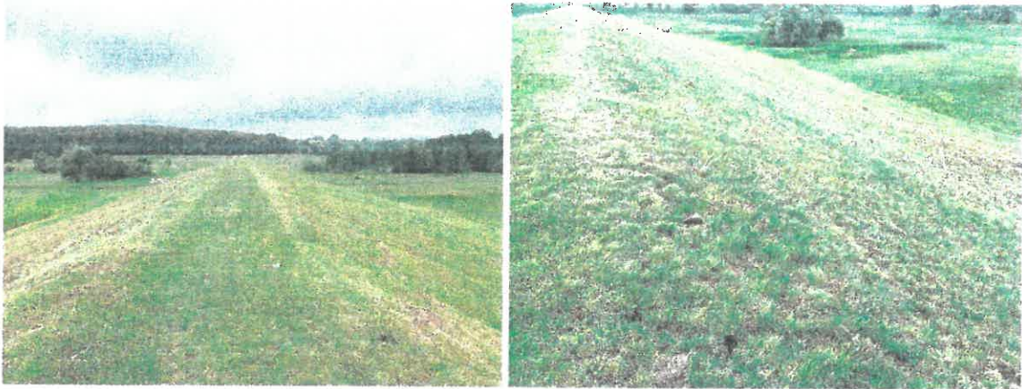
Paramentul aval și amonte, lucrările componente ale barajului și structura acestuia, nu prezintă semne de instabilitate sau alunecare.
