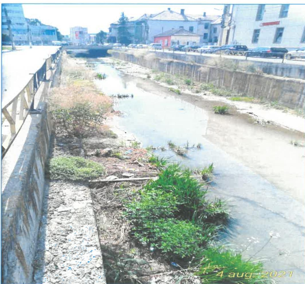
In perioada de exploatare a lucrării hidrotehnice, respectiv perioada parcursă de la punerea în funcțiune a lucrării și până în prezent, în zona supusă expertizării au fost executate doar lucrări de întreținere a albiei regularizate a Pârâului Pocioș.
